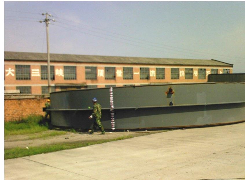
三峡工程压力钢管( \phi 12.4\text{m} \times 60\text{mm} )爆炸处理 Penstocks of the Three-Gorges Project
